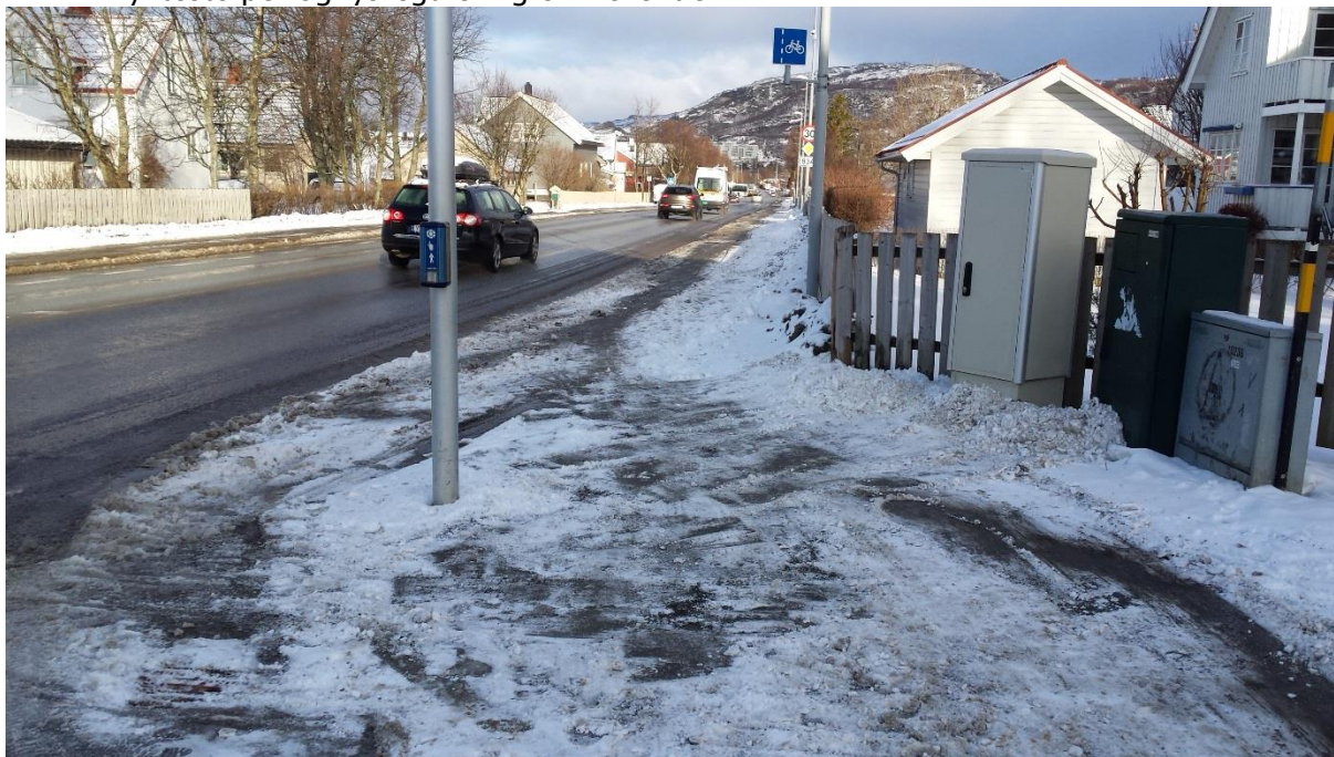
Etter brøyting av trange løsninger i Kirkeveien kl. 0915 den 10.03.2017. Snøfall 2 cm på natta. 0 grader
