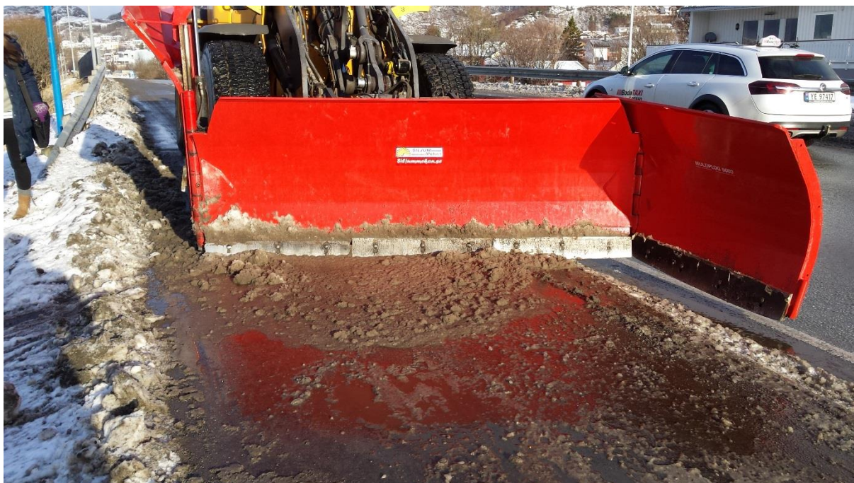
Etterrydding fortau Nordstrandveien. Deretter Kirkeveien? kl. 0915 den 10.03.2017. Snøfall 2 cm på natta. 0 grader Underentreprenøren som har kontrakten på fortauene kan ikke etterrydde dem før etter at skolen er startet pga. at de kjører på fotgjengerarealet
