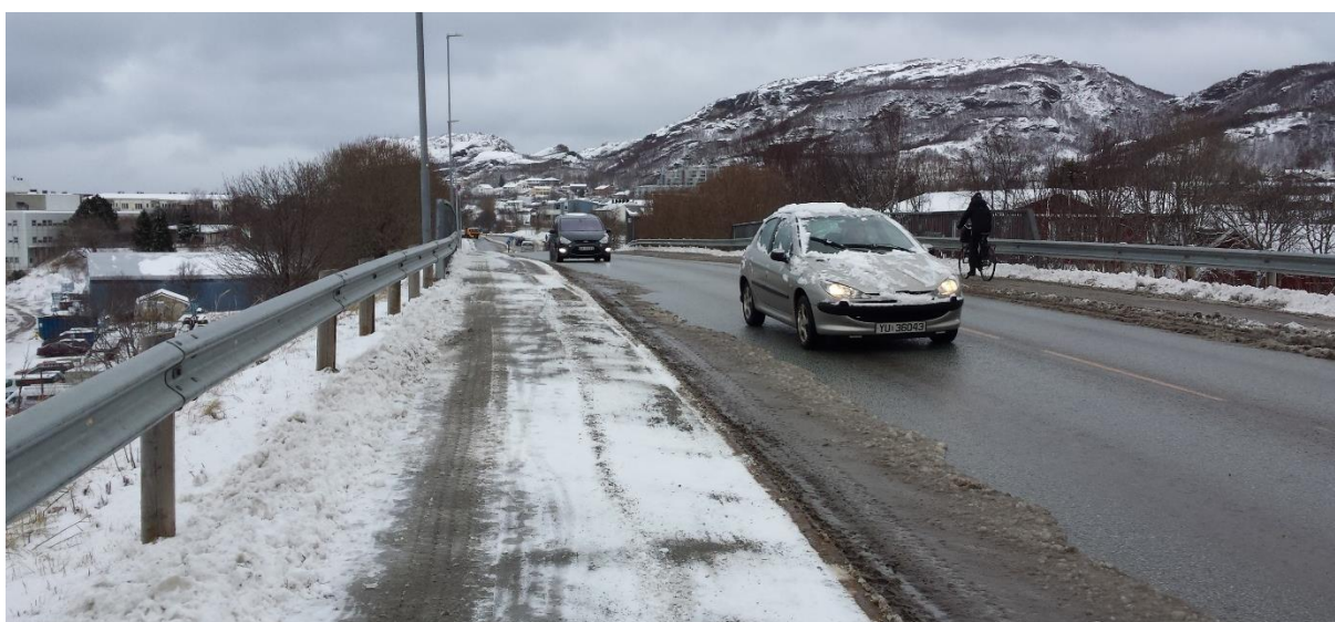
Fortau og kjørebane jernbanebrua kl. 0830 den 23.03.2017 Snøfall på 5 cm på natta. 0 grader.
